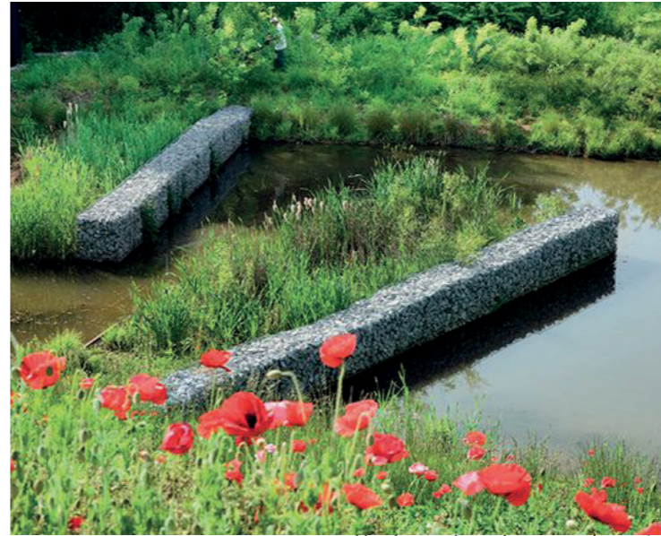
Vand som sluses igennem elementer.
