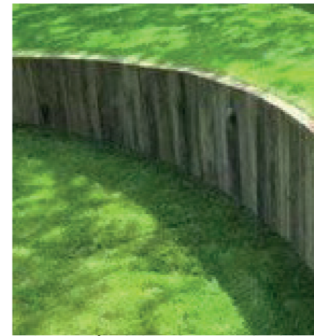
Gennemgående kantelement, palisadekant.
