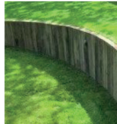
Gennemgående kantelement, palisadekant.
